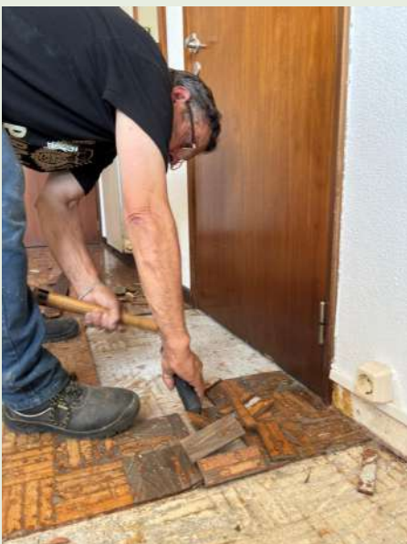
Um aspeto das obras
